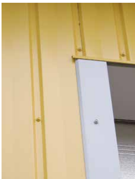
Vlevo trapézový plech W-1/ 1064 a Ocelová taška 1050. Vpravo W-15/1134
